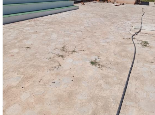
Foto 02: Trecho próximo as arquibancadas
